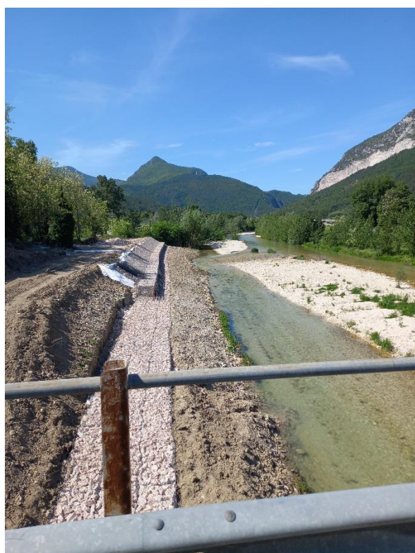
Riprofilatura sponda Dx in corso di realizzazione su tratto SS 76
