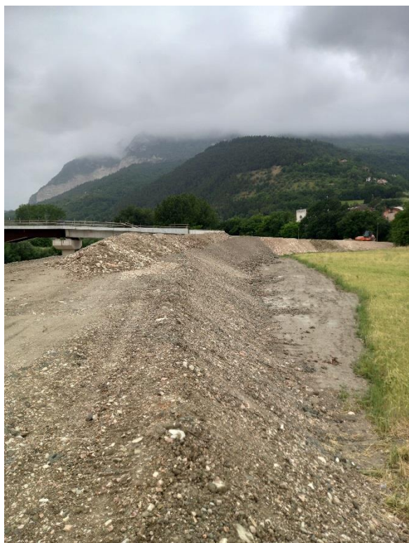
Riprofilatura sponda Sx in corso di realizzazione su nuovo ponte
