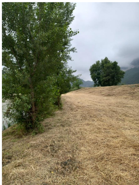
Riprofilatura sponda SX precedentemente fatta
